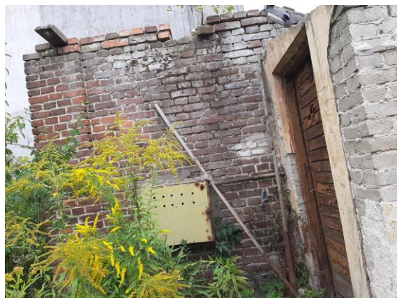
Widok narożnika budynku z dobudowanym przedsionkiem
