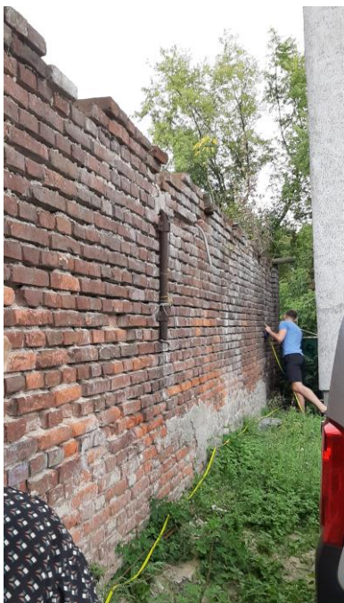
Widok ściany od strony ul. Betonowej
