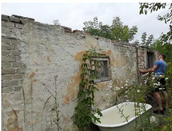
Widok ściany podłużnej dobudowanego przedsionka
